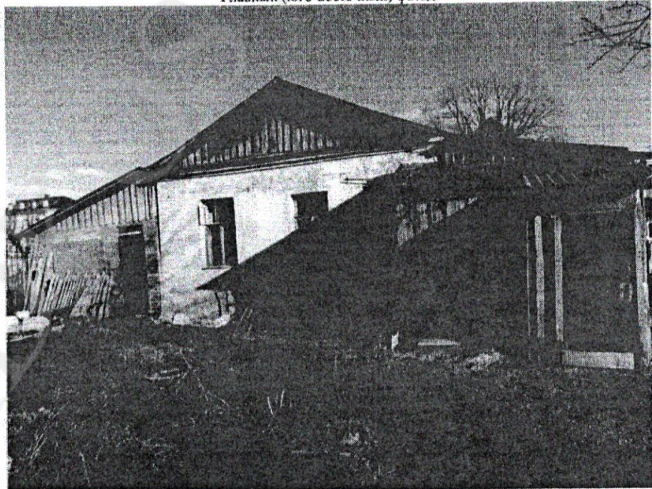
«Дом жилой Акатова, 1-я пол. XIX в.» г. Кострома, ул. Комсомольская. 31 Дворовый (северо-западный) фасад
